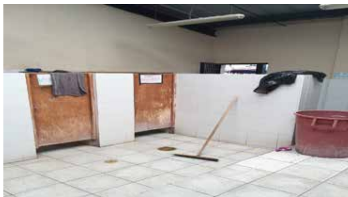
Servicios higiénicos para varones del patio del pabellón ubicados dentro de los servicios higiénicos para mujeres - EPM Jauja
