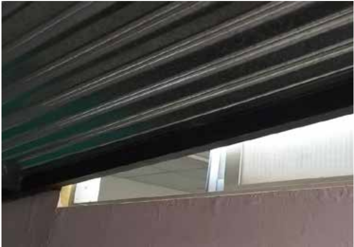
Espacio de ventilación del ambiente para la Vi (adonisterio) - EPM Jauja
